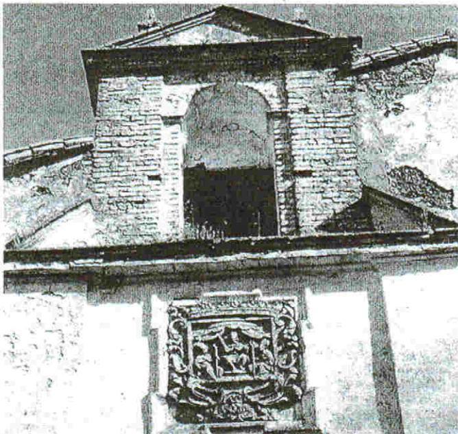
Lápida fundacional de 1684, en la fachada principal
